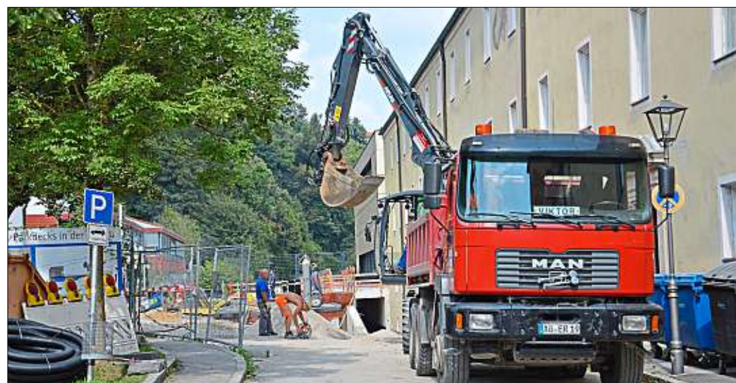
Durch vollen Baustellen-Betrieb mussten die Kinder zum Maria-Ward-Kindergarten gehen, beklagten die Eltern am Donnerstag. Die Stadt verspricht umgehend Abhilfe. – Foto: cts
